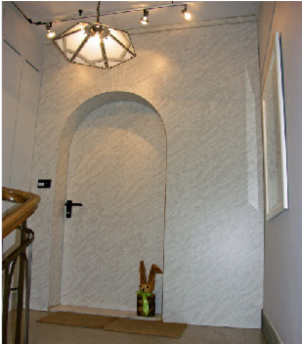
Kunststoffrahmen mit exessiver Türe. Beckenhofstr. 61, 8006 Zürich (1919)
