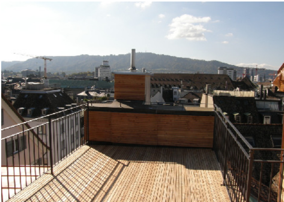
Adessiver Holzrost. Fortunagasse 38, 8001 Zürich
